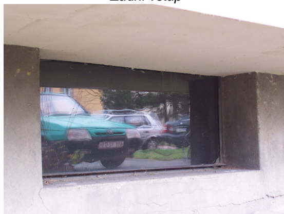
Okno suterénu, zateplení podlahy nad exteriérem
