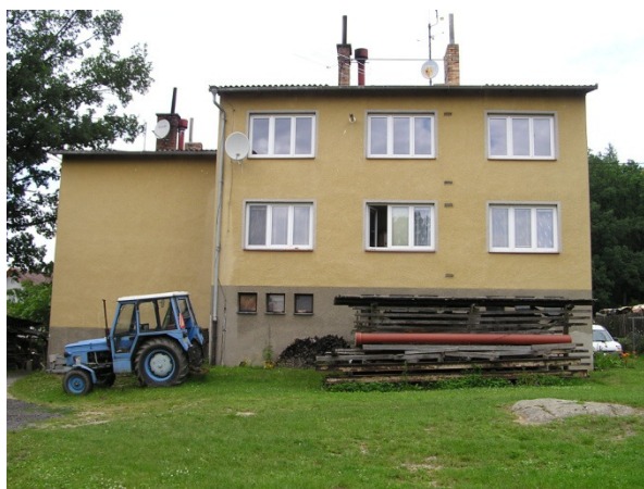
jižní průčelí objektu
