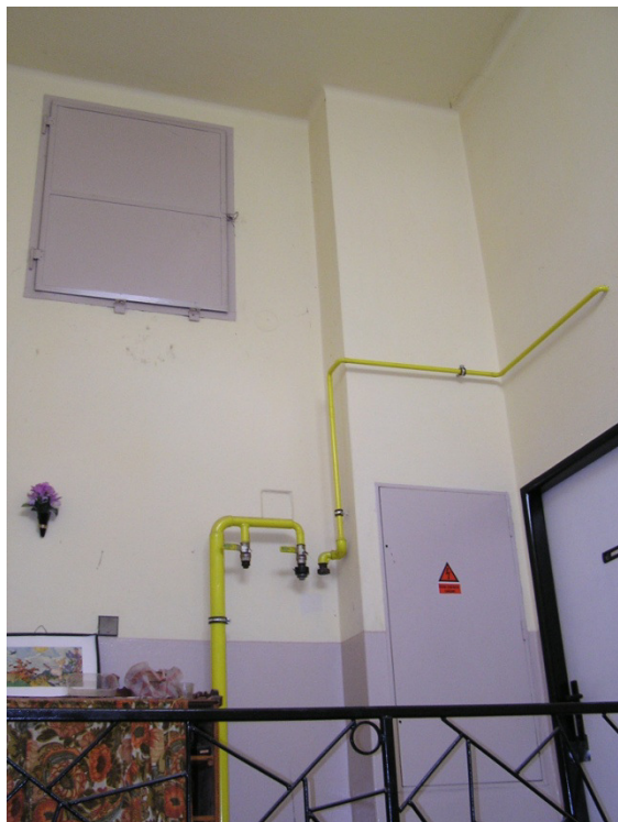
Schodišťový prostor, výlez do střechy
