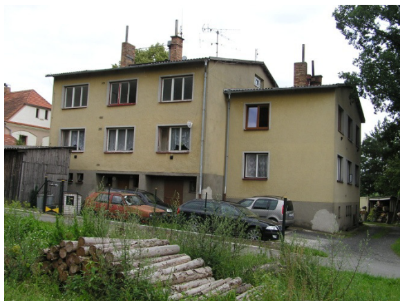
Severní průčelí objektu
